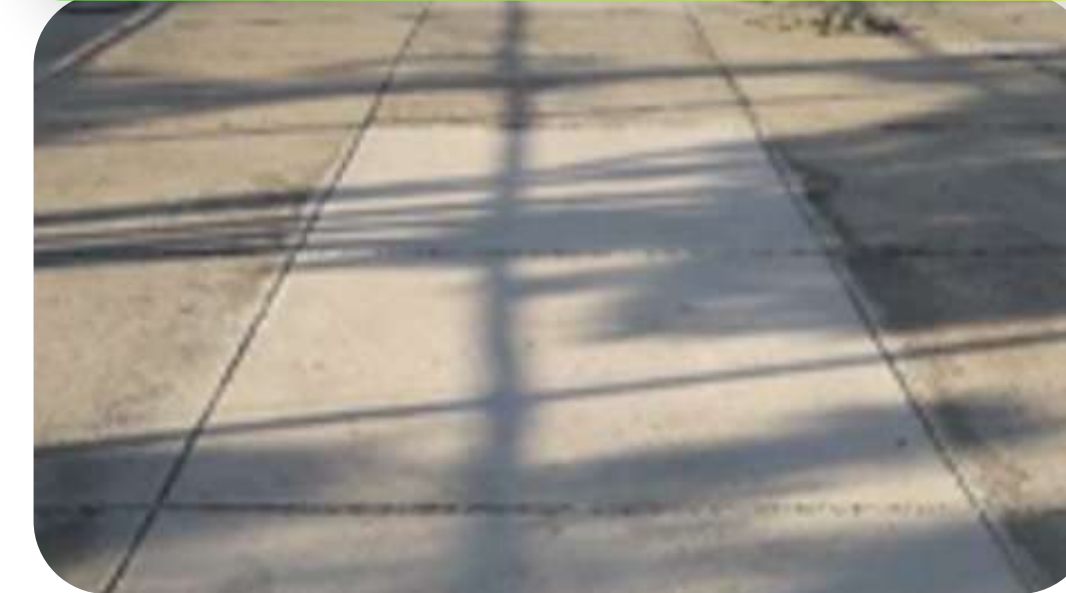
Después de Intervención
