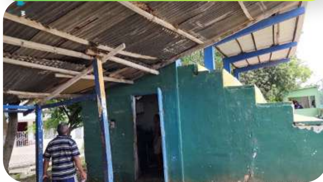
Antes de Intervención
