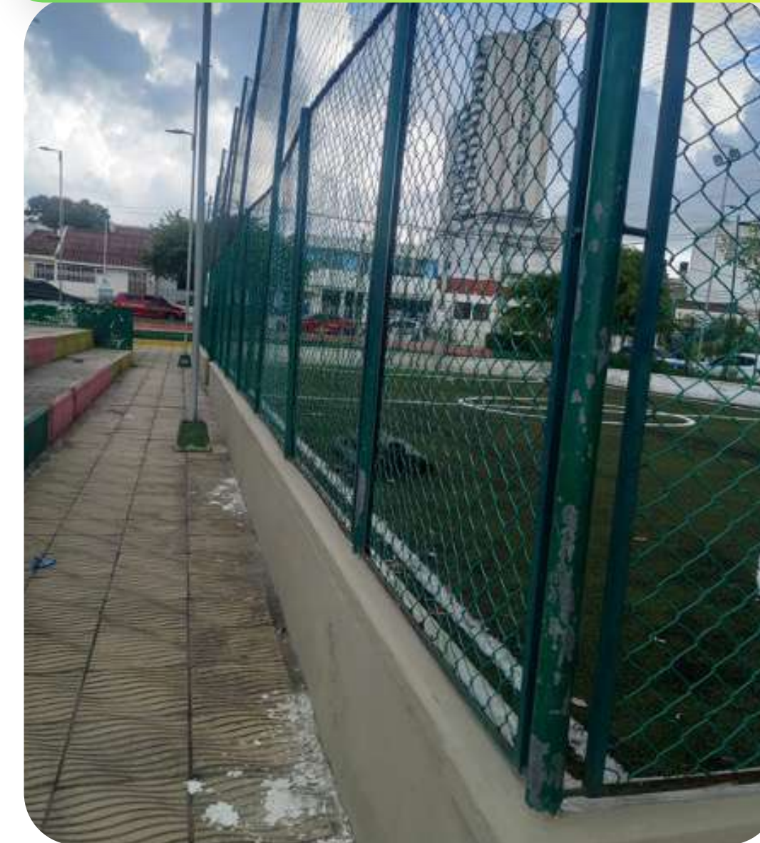
Después de Intervención
