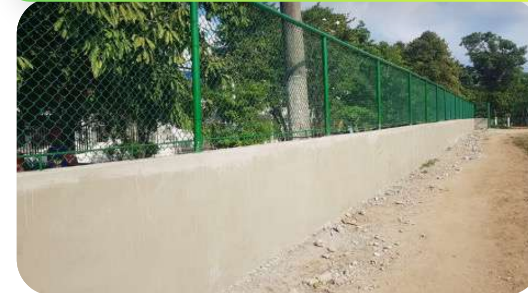
Después de Intervención
