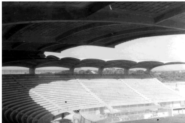
Imagen 4. Estructura interna del estadio de Béisbol con su cubierta y graderías
