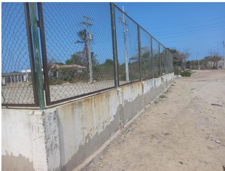
Vista general del estado cerramiento perimetral (Muro en mamposteria, malla eslabonada y estructura metalica)
