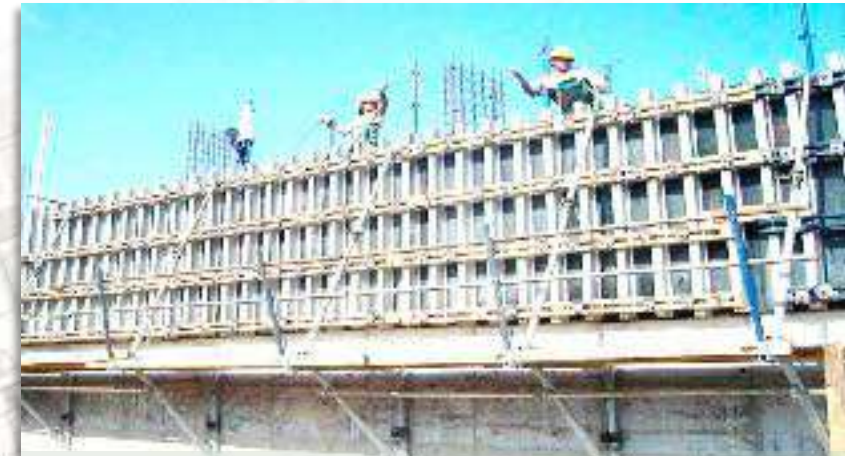
Figura 31. Muro vaciado a la vista. Fuente: pagina web unispan.com.co.
