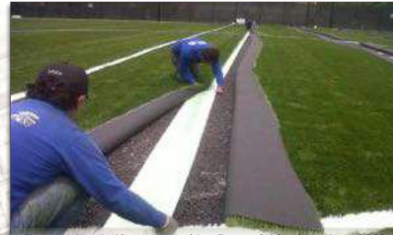
Figura 27. Instalación grama sintética. Fuente: SH Sintéticos hascal SAS.
