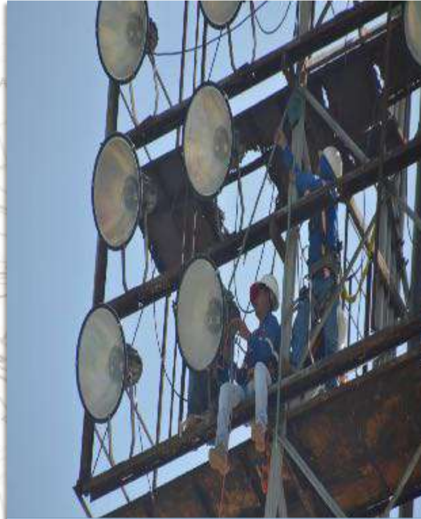
Figura 30. Instalación de torre de iluminación. Fuente: El Universal.
