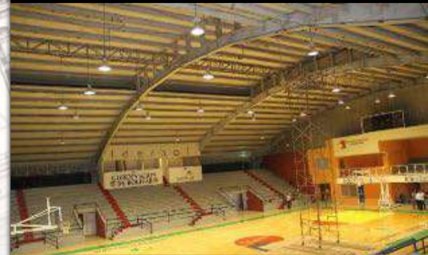
Figura 2. Iluminación Bernardo Caraballo. Fuente: Akypescraper city.
