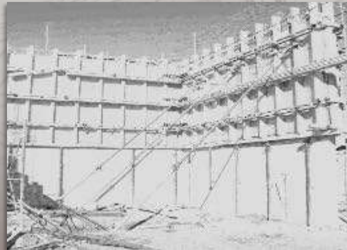
Figura 30. Muro vaciado a la vista. Fuente: pagina web unispan.com.co.
