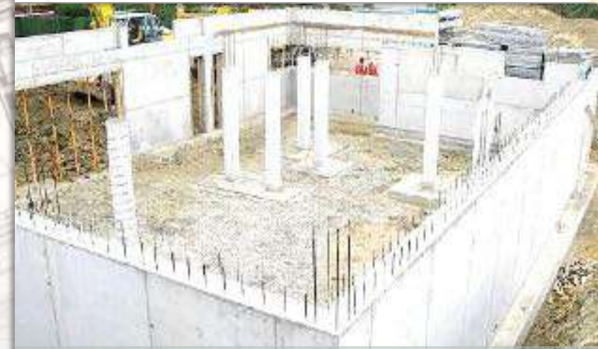
Figura 32. Cerramiento Muro Vaciado. Fuente: Pagina web cuevadelcivil.com.
