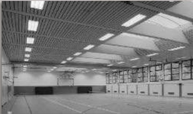
Figura 14. Iluminación en techo empotrada. Fuente: Licht.
