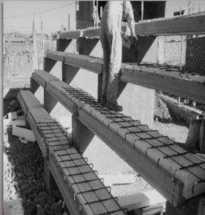
Figura 12. Gradería de Losas Aligeradas con Viguetas. Fuente: Tecnopreco.
