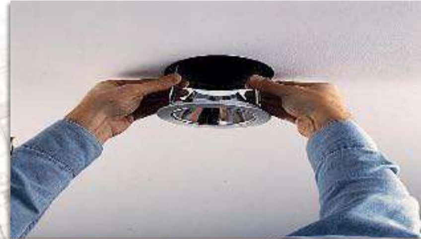
Figura 15. Instalación de iluminación empotrada. Fuente: Construguia.
