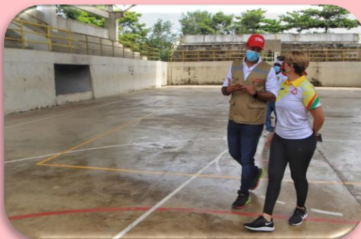
Visita de inspección a escenarios deportivos.
