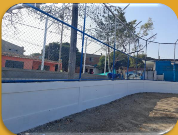
Campo de Softbol de Villarubia – Escenario en proceso de reconstrucción, reanudación de obra 18 de enero de 2022
